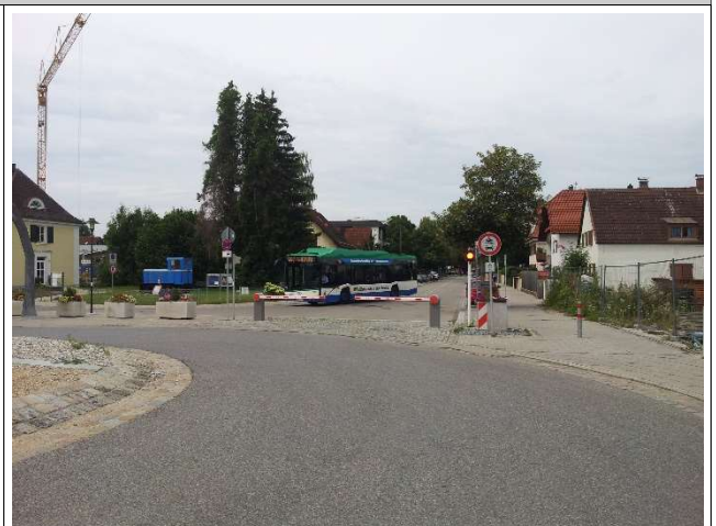
Beispiel: Schrankenanlage Bahnhof Unterföhring
