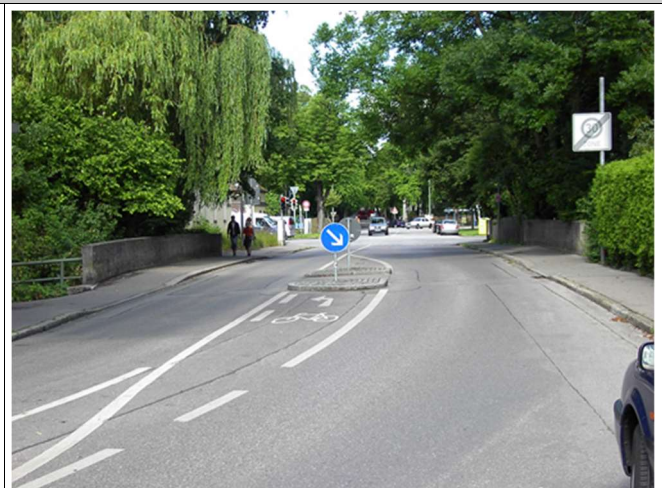
Beispiel: München-Pasing, Theodor-Storm-Straße
