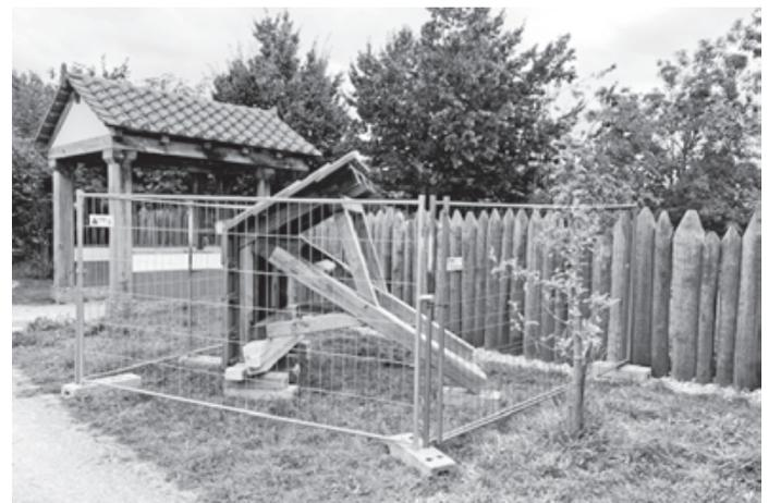
(may) Bei einer Überprüfung der Standfestigkeit der Überdachung des Römerbrunnens wurde festgestellt, dass diese nicht mehr gewährleistet ist. Die beiden Standpfosten sind am Übergang in den Boden mit Fäulnis befallen. Nachdem eine Reparatur kurzfristig nicht möglich ist, wurde die Überdachung abgebaut und in der Nähe mit einem Bauzaun gesichert gelagert.
