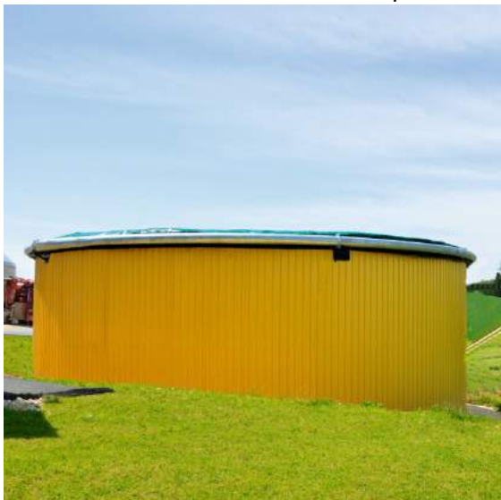
Langzeitwärmespeicher, Quelle: Cupasol
